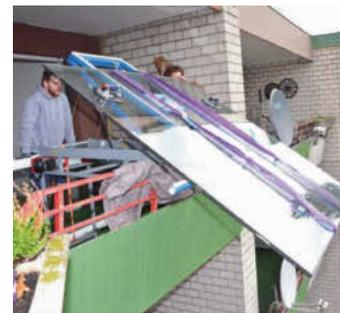
*/ Der Bauminilift kann ein Gewicht von bis zu 250 kg auf eine Höhe von maximal 18 m transportieren.*
