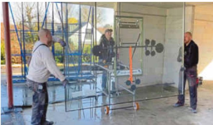
*/ Schnell vom Baulift zum Glasroboter: Der Baustellenhelfer Flipper wurde so optimiert, dass er jetzt Verglasungen von bis zu 300 kg ermöglicht.*
